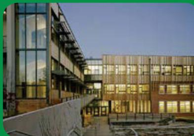
Установлены оптические системы, которые регулируют поток солнечного света, направляя его в темные помещения здания. На окнах, которые выходят на солнечную сторону, созданы специальные затемнения, защищающие внутренние помещения от перегрева.
