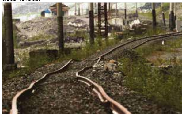
Fig. 2.8.8. Porțiuni de cale ferată deteriorată.
