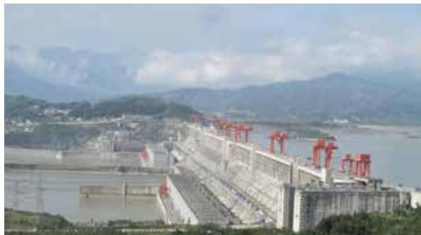
Fig. 3.1.10. Centrala hidroelectrică "Trei Defileuri", China.
