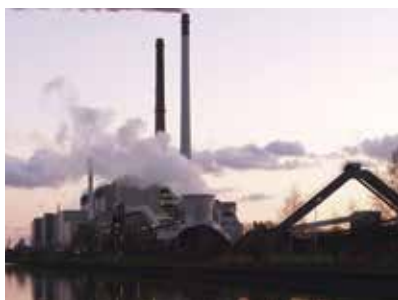
Termocentrală pe cărbune.
