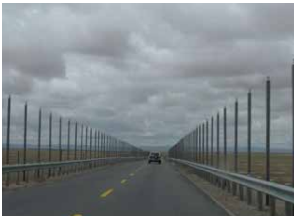
Fig. 2.8.13. Drum cu termosifoane de înghețare.
